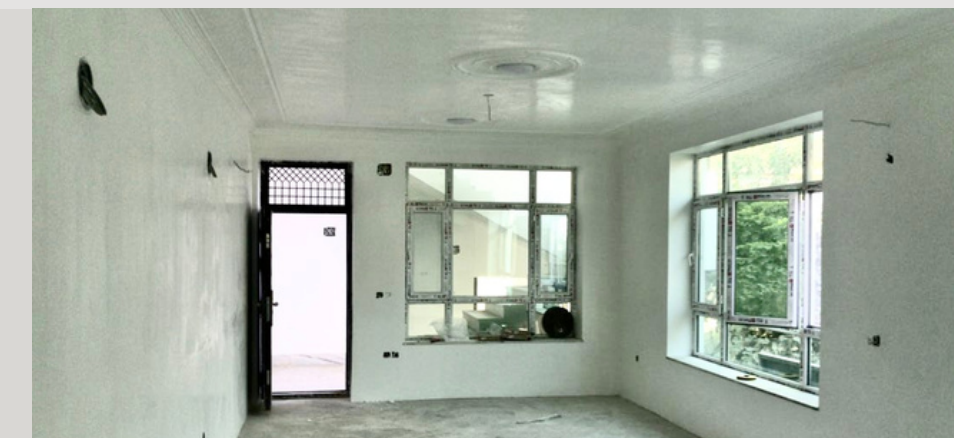
拠点施設 EJAADセンターの内部
